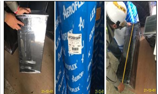
งานตรวจสอบท่อแอร์ (Air Duct) CC1.2
