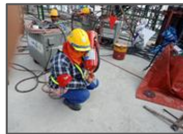
ตรวจสอบถังดับเพลิง
