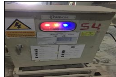
ตรวจตู้ไฟฟ้า
