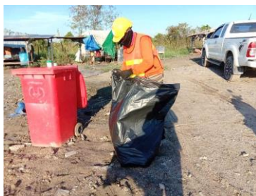
การเก็บขยะในพื้นที่ก่อสร้าง
