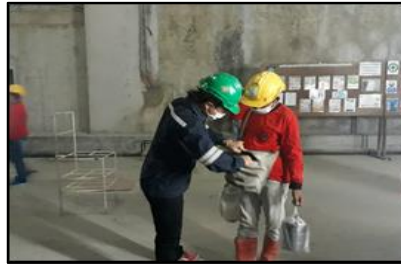
ตรวจพนักงานก่อนเข้าอุโมงค์
