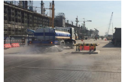
ฉีดพรมน้ำในพื้นที่ก่อสร้าง
