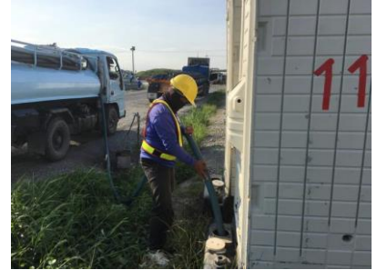
สูบล้างปฏิภูลท้องน้ำในพื้นที่ก่อสร้าง
