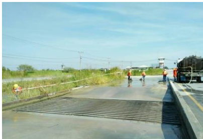
การทำความสะอาดบ่อล้างล้อ
