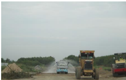
ฉีดพรมน้ำในพื้นที่ก่อสร้าง
