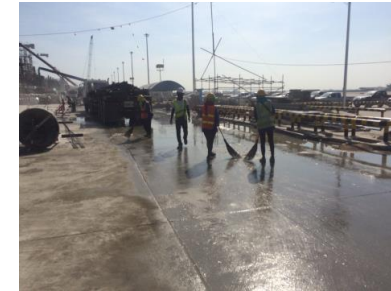
การทำความสะอาดถนนในพื้นที่ก่อสร้าง
