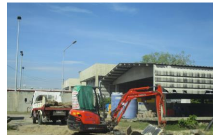
จัดเก็บเศษวัสดุก่อสร้างในพื้นที่ก่อสร้าง
