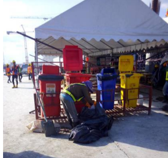
การเก็บขยะในพื้นที่ก่อสร้าง
