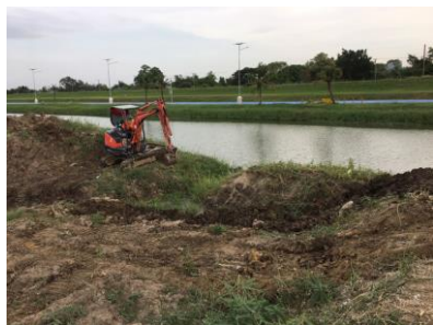
ปรับปรุงทางระบายน้ำ
