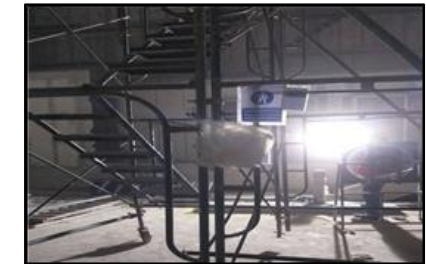
ตรวจสอบนั่งร้าน
