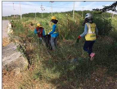
จัดเก็บขยะมูลฝอยในพื้นที่ก่อสร้าง
