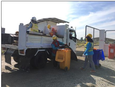
จัดเก็บขยะในพื้นที่ก่อสร้าง
