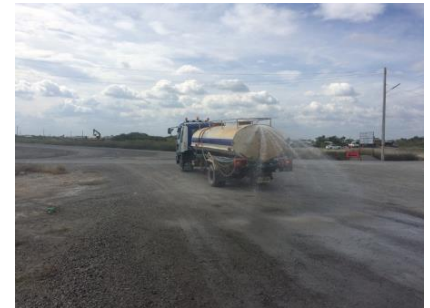
ฉีดพรมน้ำในพื้นที่ก่อสร้าง
