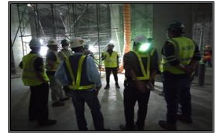
ตรวจงานด้านความปลอดภัย
