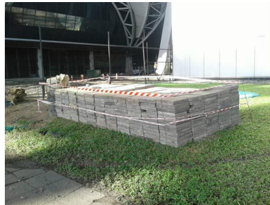
กั้นขอบเขตวัสดุก่อสร้าง
