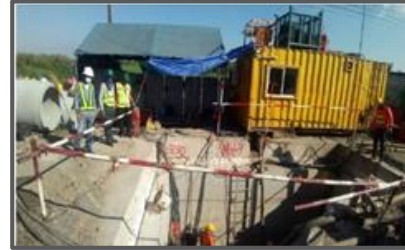
ตรวจความปลอดภัยพื้นที่หน้างาน
