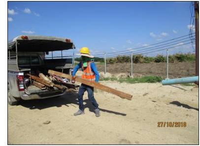
จัดเก็บเศษวัสดุก่อสร้างในพื้นที่ก่อสร้าง
