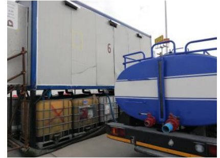
สูบล้างปฏิภนท่อน้ำในพื้นที่ก่อสร้าง
