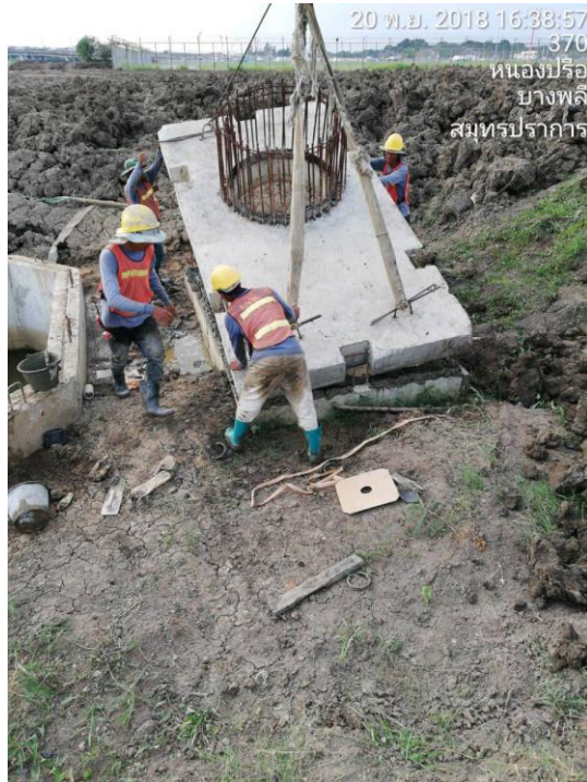
งานเข้าแบบฝาบ่อ MH. (Scada)
