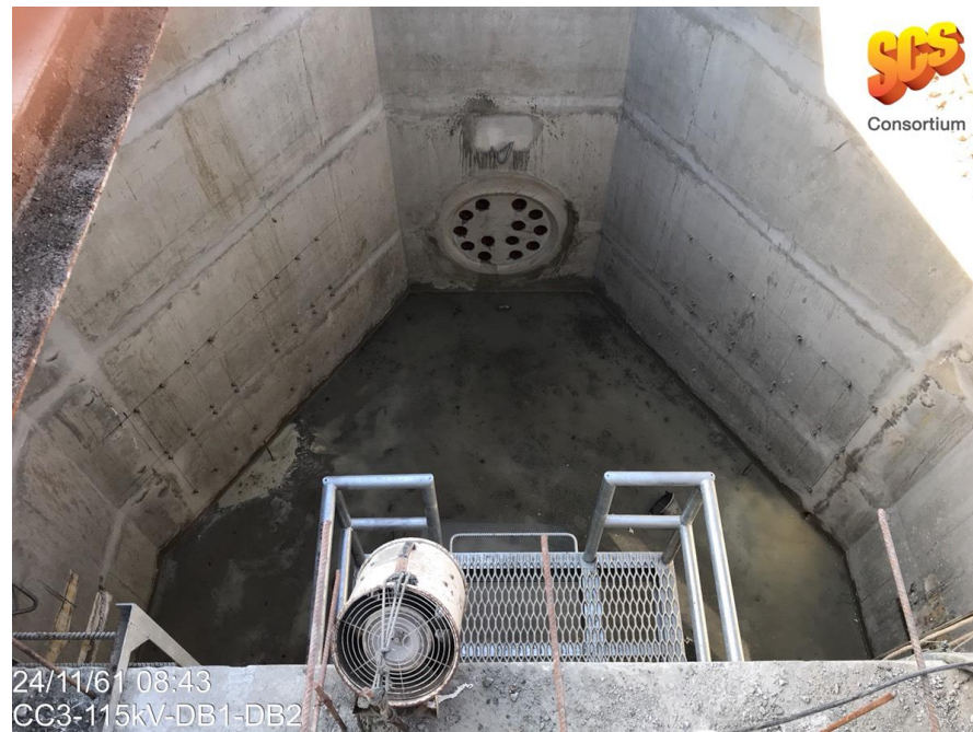
งานท่อร้อยสายไฟ
