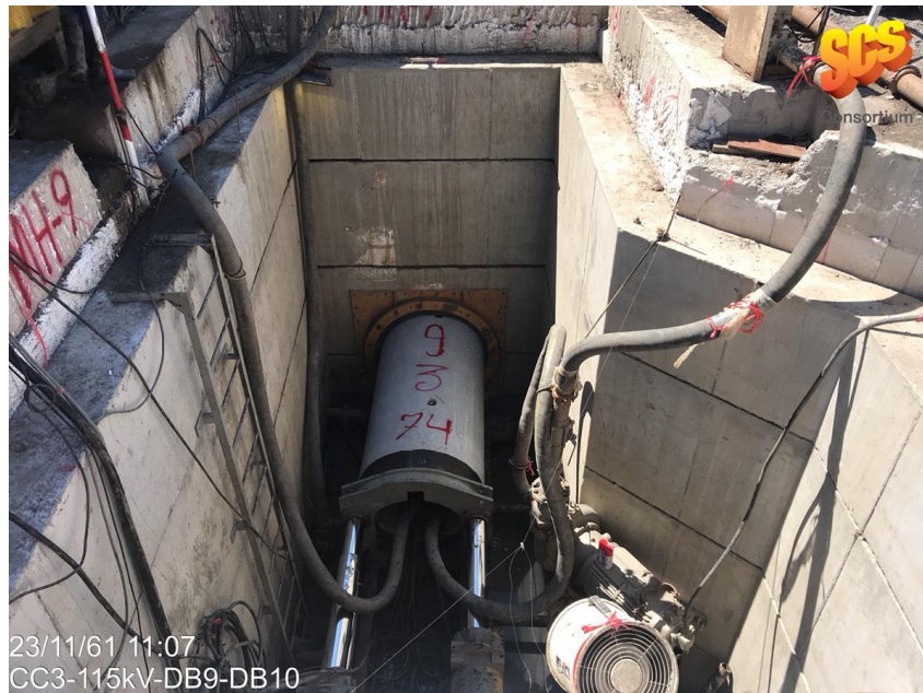
งานเดินท่อลอด MH9-MH10
