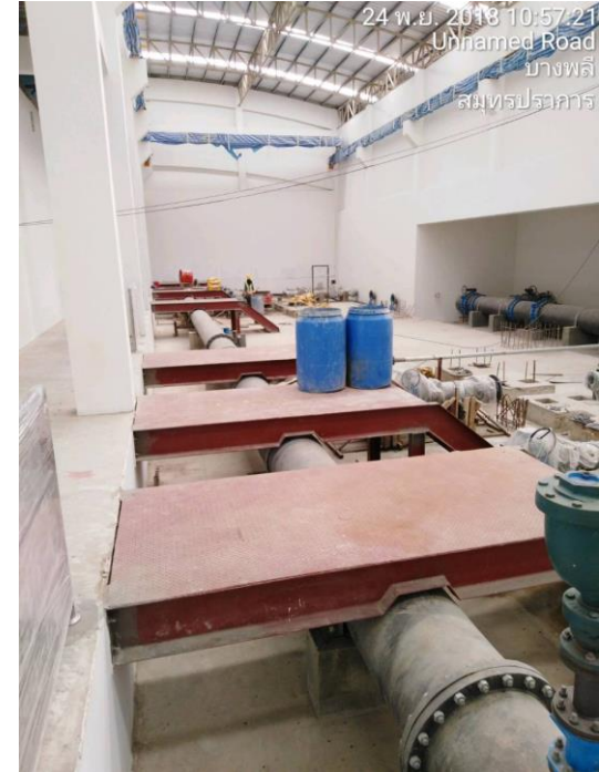
งานปรับพื้นใต้ห้อง Switch Gear
