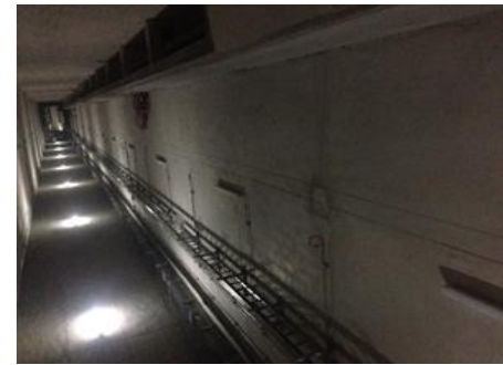
งานติดตั้งคอมไฟช่อง APM
