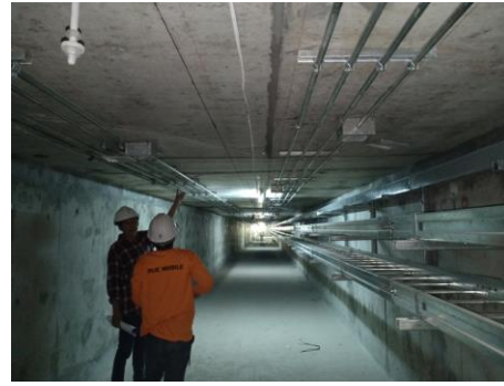
งานติดตั้งท่อระบบไฟฟ้าแสงสว่าง, Power for Jet Fan & Receptacle ภายใน Utility Tunnel
