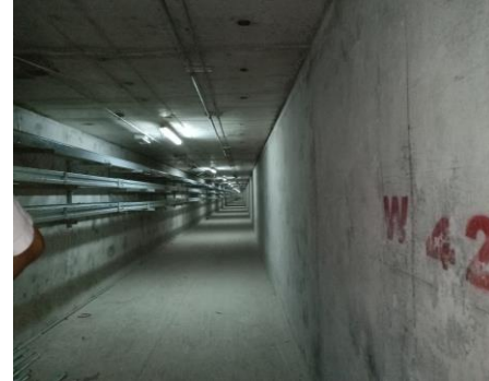
งานติดตั้งท่อระบบไฟฟ้าแสงสว่าง, Power for Jet Fan & Receptacle ภายใน Utility Tunnel
