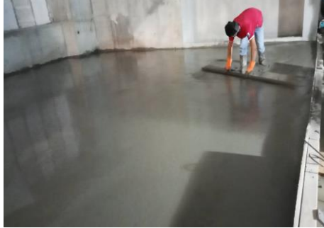
งาน Topping ชั้น B2
