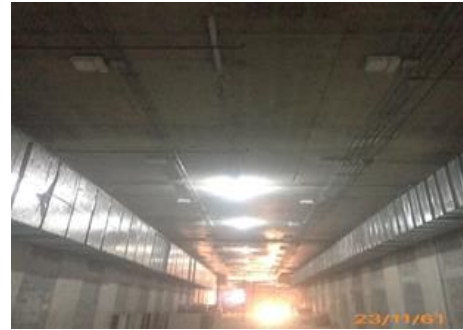
งานติดตั้งไฟ Depot โรงซ่อมบำรุง
