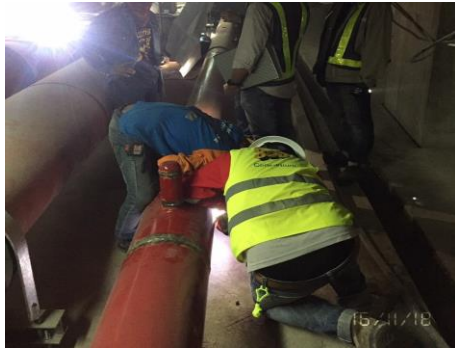
งานติดตั้งท่อดับเพลิงใน Utility Tunnel
