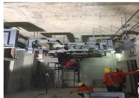
งานติดตั้ง Busduct และคอมไฟห้อง Dynamic ups ห้อง DConcourse D
