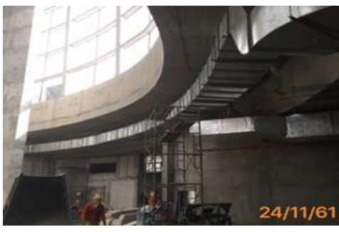
งานติดตั้งท่อลมระบายอากาศในอุโมงค์
