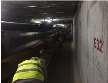
งานติดตั้งท่อดับเพลิงใน Utility Tunnel
