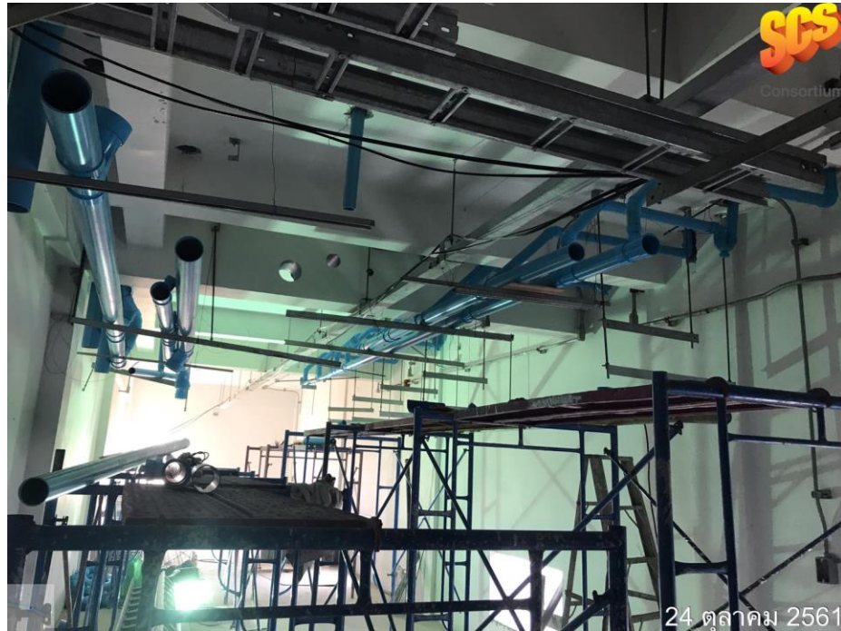
งานติดตั้งระบบท่อสุขาภิบาลห้องน้ำ ชั้น 1 และ 2
