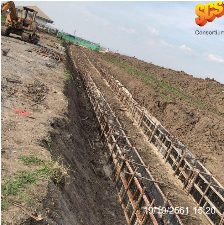
งานเข้าแบบDB.ช่วงMH.61-62(24kv) ,MH.39-40(Scada)
