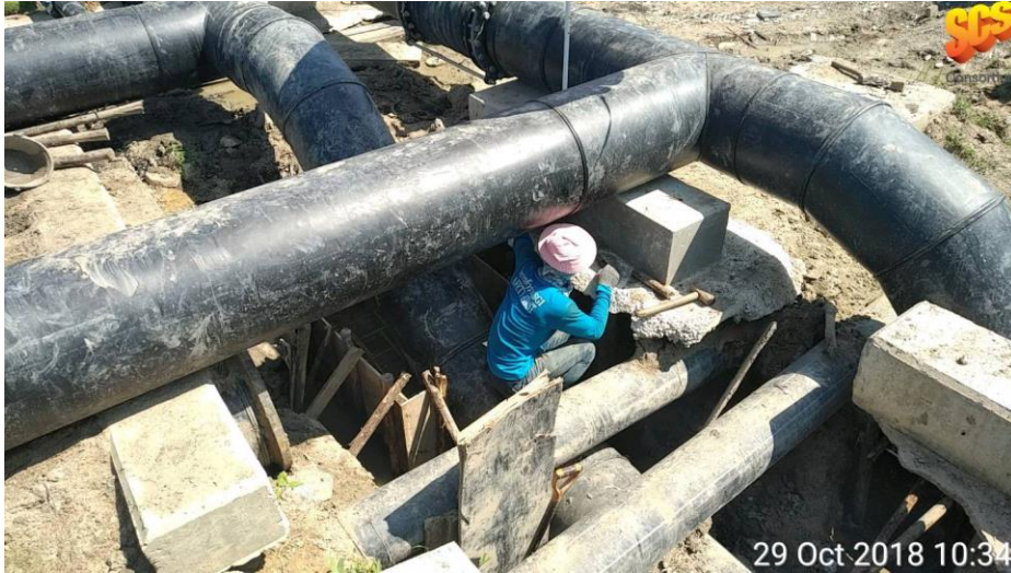
งานผูกเหล็กเข้าแบบ ฐานรับแรงกระแทก จำนวน 4 ฐาน หน้าบ่อ Bio-2
