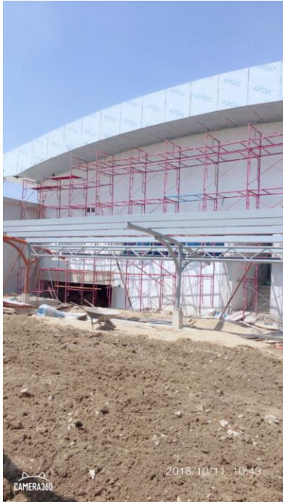
งานเชื่อมโครงหลังคาโรงจอดรถ ด้านข้างอาคาร
