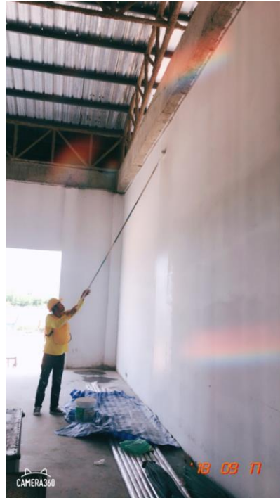
งานทาสีผนังภายใน ภายนอกของอาคาร
