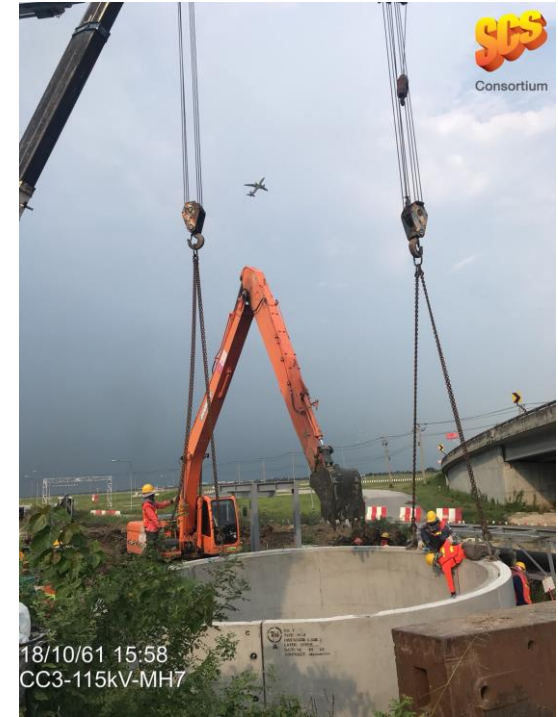
งานจมบ่อ Manhole
