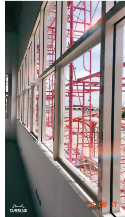
งานติดตั้งบานประตูหน้าต่าง อลูมิเนียม
