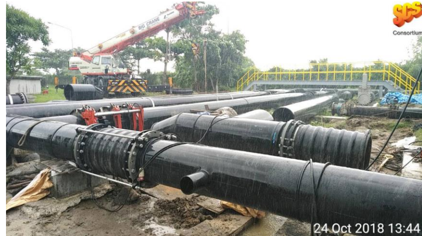
งานเชื่อมต่อ HDPE 560 mm บริเวณหน้าบ่อ Bio-2
