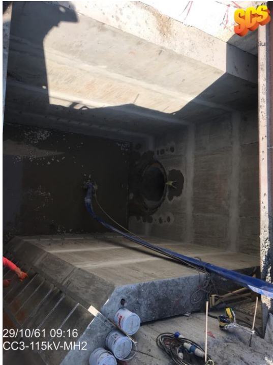
งานติดตั้ง Pulling, Ground rod, Expansion bolt for cable rack
