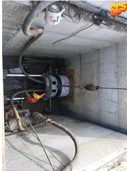
งานดันท่อลอด (Pipe Jacking)
