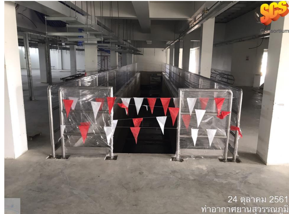
งานติดตั้งราวกันตก ของบ่อรับ 115 kV. และ บ่อUtility
