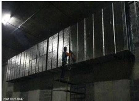
งานติดตั้งท่อลมระบายอากาศในอุโมงค์
