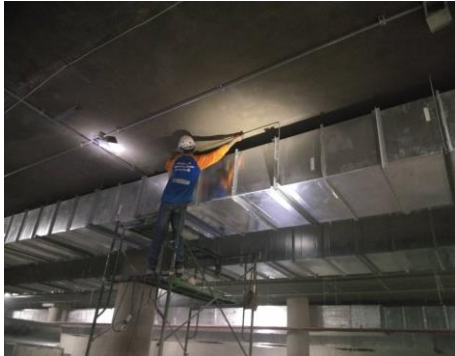
งานตรวจสอบ Air Duct ที่ Concourse D
