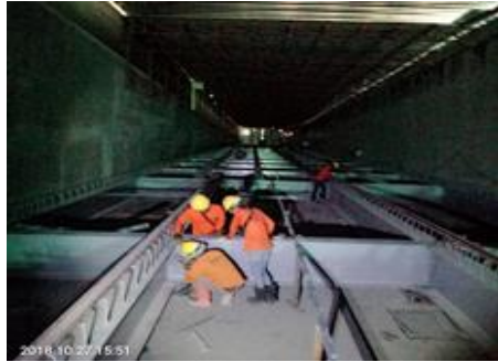
งานติดตั้งแบบเกราะที่ Baseplate / Ramp
