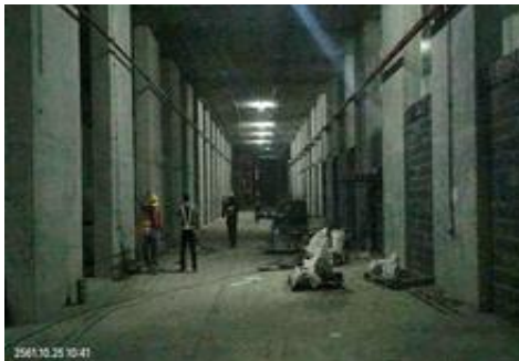
งานติดตั้งท่อดับเพลิงในอุโมงค์
