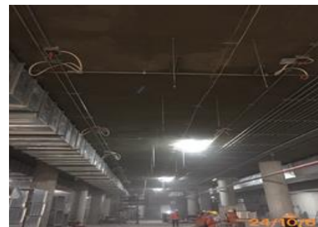
งานติดตั้งท่อเหล็กของระบบ Lighting APM station
