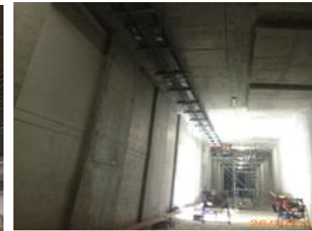
งานติดตั้ง Busduct
