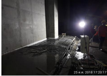
งาน Topping ชั้น B2
