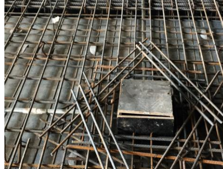
งานติดตั้งระบบ Grounding
