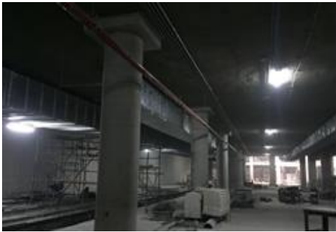
งานติดตั้งท่อลมระบายอากาศ APM Station at concourse D
