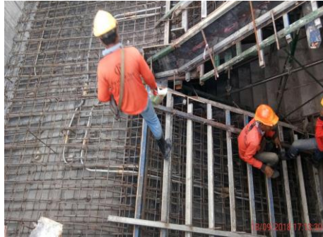
งาน บันได
