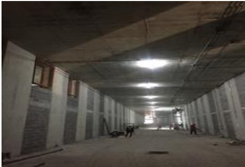
งานติดตั้งระบบสปริงเกอร์ในอุโมงค์
