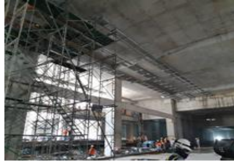
งานติดตั้งท่อ งานเดินท่อ Mainfeeder sat
