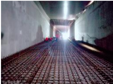
งานวางเหล็กพื้น Ramp ด้านตะวันตก
