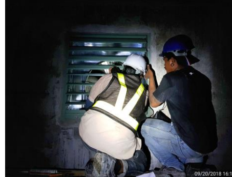
งานตรวจสอบระบบ ระบายอากาศชั่วคราว ห้อง B1-114
