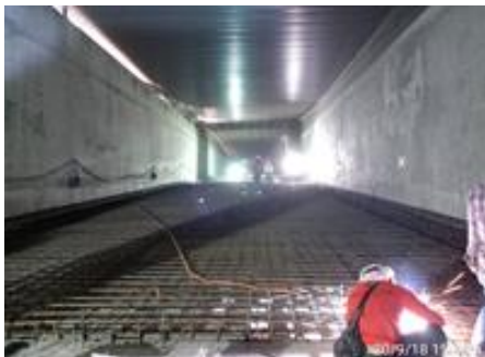
งานตั้งแบบและตั้งระดับพื้น Ramp
