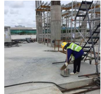
ทำความสะอาดพื้นที่ก่อสร้าง
