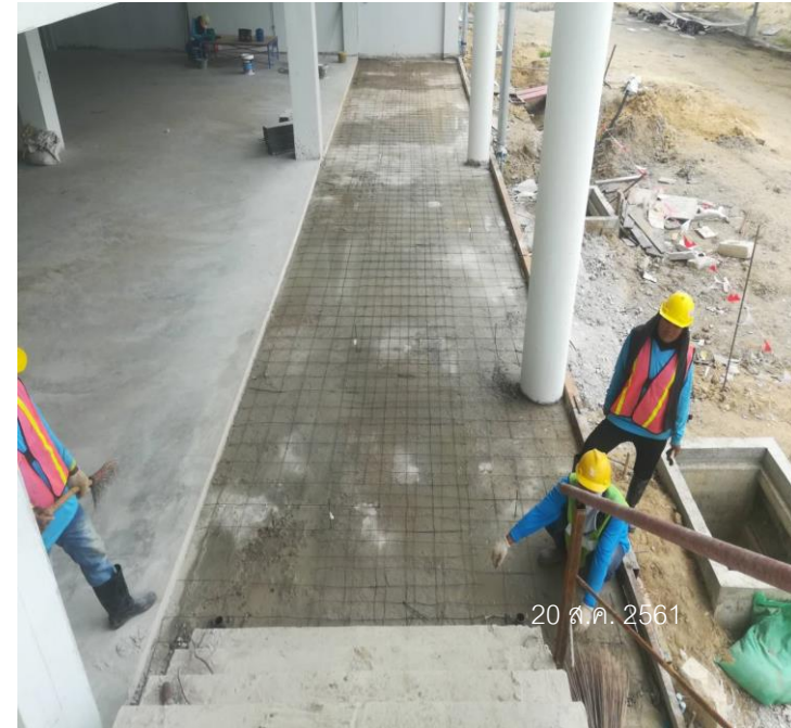
เก็บงานผูกเหล็กเตรียมเทคอนกรีตปรับระดับ พื้นพร้อมทำความสะอาด ชั้น 1
