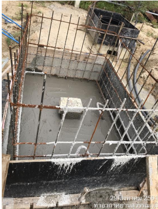
งานเทคอนกรีต บ่อ CCTV
