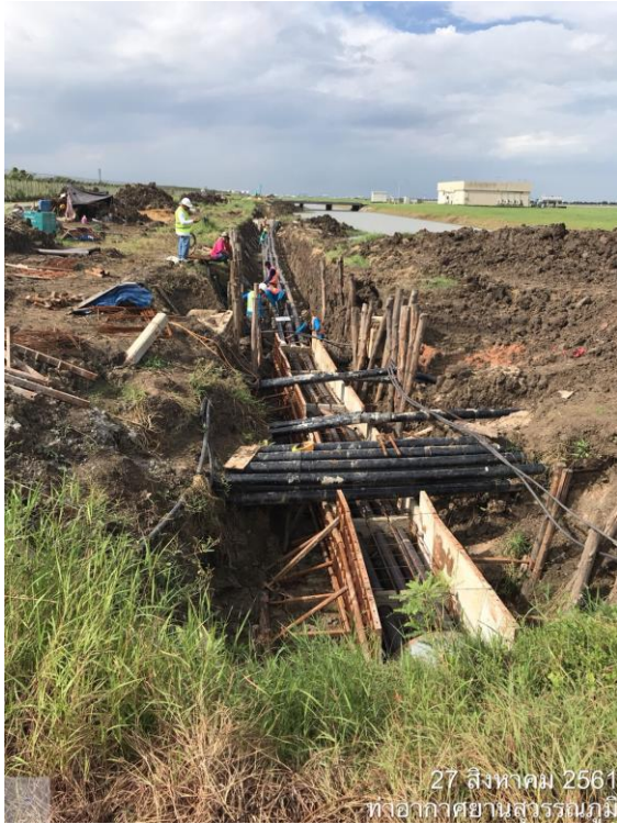
ติดตั้งDB.ช่วงMH.69-70(24kv)
