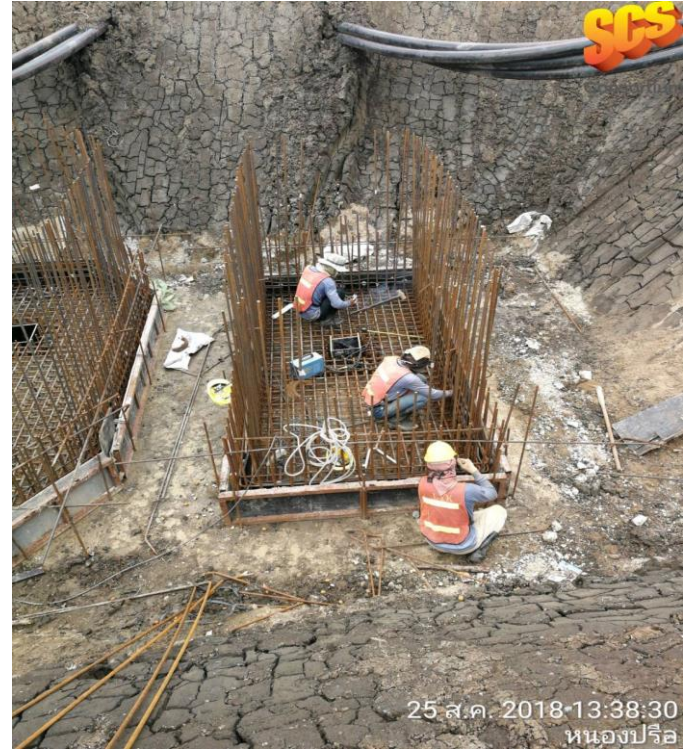
เข้าแบบพื้นบ่อMH.37(Scada)
