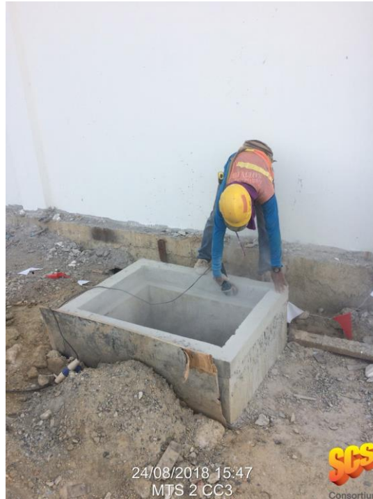
งานฝาบ่อระบายน้ำรอบอาคาร
