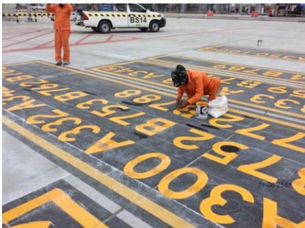
ตรวจสอบงาน Marking ( Multiple Marshaller Stop Line) บริเวณ APRON ทิศเหนือ
