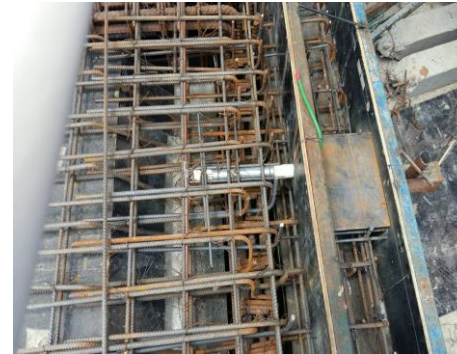
งานติดตั้งระบบ Grounding
