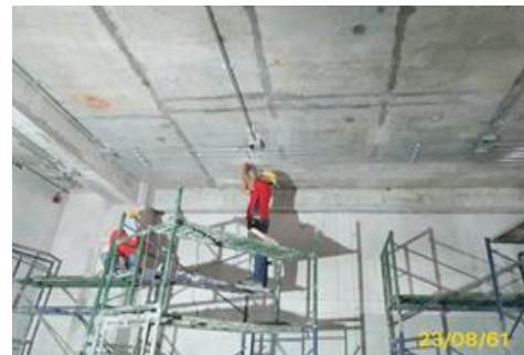
งานติดตั้งท่อติดตั้งท่อ งานระบบ Lighting Recapture CCD ห้อง Keydate
