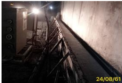
งานเทคอนกรีต Walkway Service road
