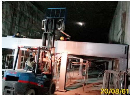
งานประกอบโครงเหล็ก Ramp
