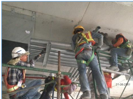
งานเดินท่อไฟฟ้าจ่ายตู้ไฟฟ้าชั่วคราวแล้วเสร็จด้านทิศเหนือมายังห้องไฟฟ้า
