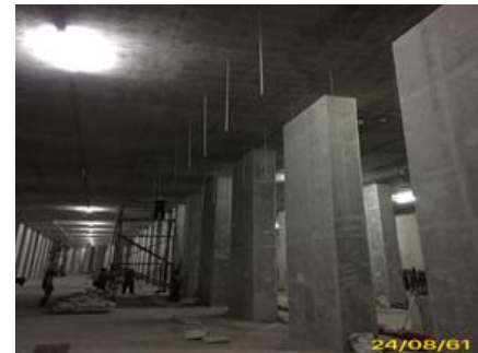
งานติดตั้งท่อ support ท่อลมระบาย อากาศในอุโมงค์
