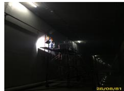
งานดับเพลิงในอุโมงค์
