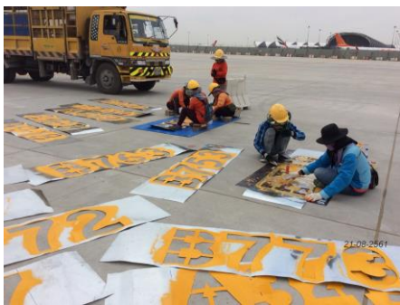
ตรวจสอบงาน Marking ( Multiple Marshaller Stop Line) บริเวณ APRON ทิศเหนือ
