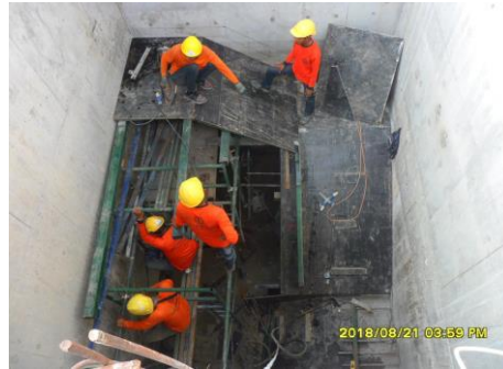
งาน บันได
