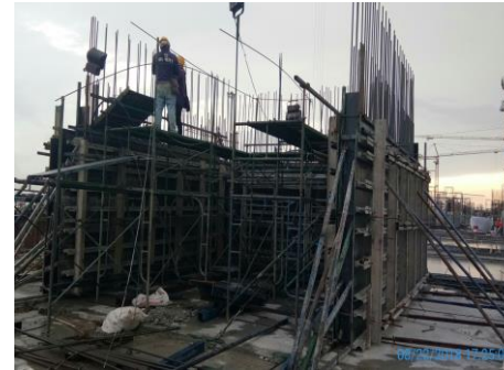
งาน RC Wall
