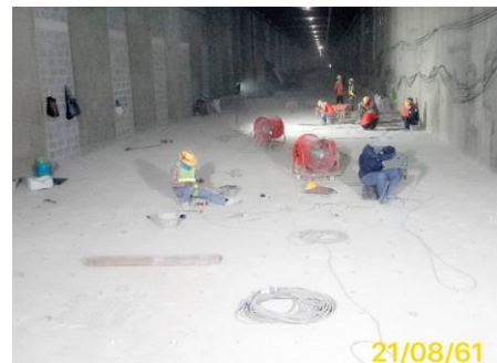
งานเจาะพื้นเสียบเหล็ก Ramp
