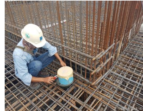
งาน Pipe for Drain
