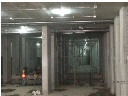
งานเดินท่อไฟฟ้าจ่ายตู้ไฟฟ้าชั่วคราวแล้วเสร็จด้านทิศเหนือมายังห้องไฟฟ้า
