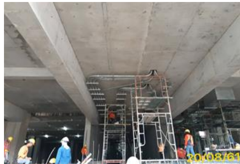
งานติดตั้งท่อ Mainfeeder ขึ้นห้อง MDB
