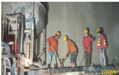
งานเทคอนกรีต Emergency walkway
