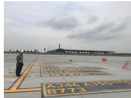
ตรวจสอบงาน Marking ( Multiple Marshaller Stop Line) บริเวณ APRON ทิศเหนือ
