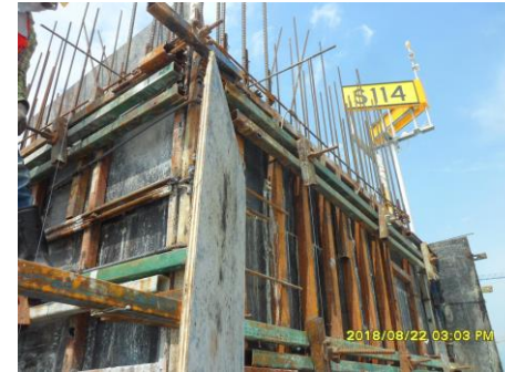
งาน Boarding Bridge
