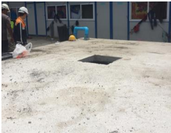
ปรับปรุงระบบบำบัดน้ำเสียบ้านพักคนงาน
