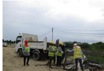
จัดเก็บเศษวัสดุก่อสร้างในพื้นที่ก่อสร้าง
