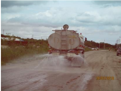
ฉีดพรมน้ำในพื้นที่ก่อสร้าง
