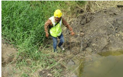
ติดตั้งตะแกรงดักขยะ
