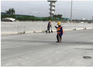
การทำความสะอาดถนนในบริเวณพื้นที่ก่อสร้าง
