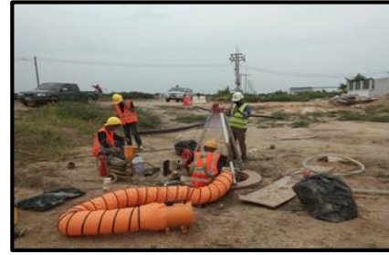
การทำงานในพื้นที่อับ อากาศ
