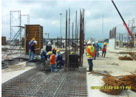
งาน Slab B1
