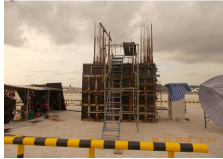
งานฐานราก Boarding Bridge
