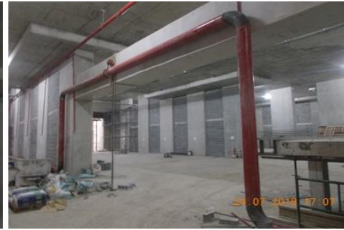
งานติดตั้งท่อระบบดับเพลิง
