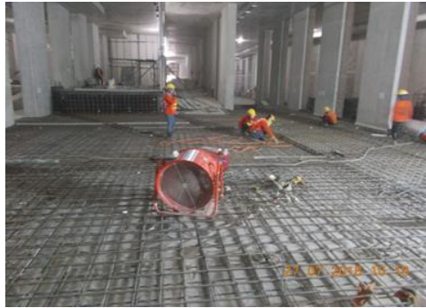
งาน SLAB APM DEPOT
