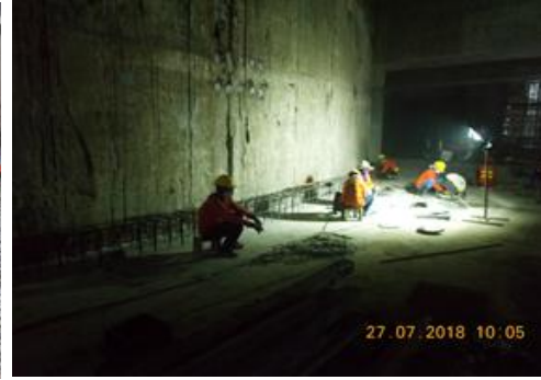
งาน Walk Way at Service Roadway
