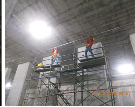
งานติดตั้งท่อ Conduit ระบบไฟฟ้า New Tunnel
