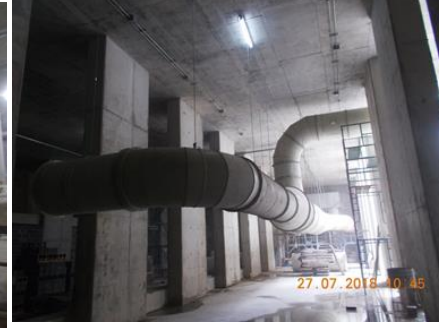
งานติดตั้งระบบระบายอากาศ
