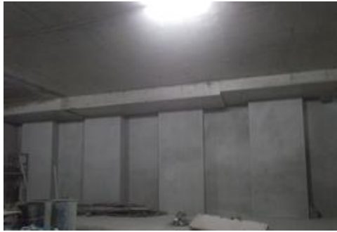
งานฉาบผนังมวลเบาสำเร็จรูปบริเวณห้อง OCC APM DEPOT
