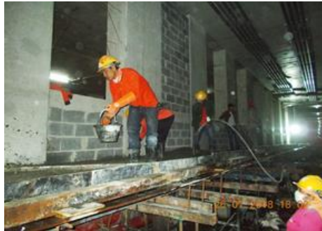
งาน Emergency Walk Way
