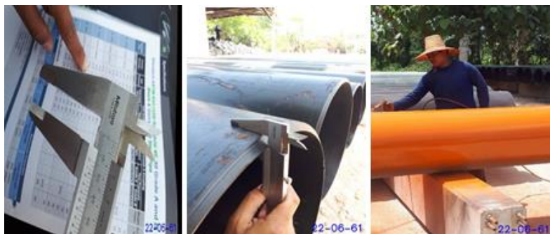
ตรวจสอบท่อเหล็ก และงานสีทาท่อ สัญญา CC1/2
