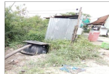
ติดตั้งถังบำบัดน้ำเสียในพื้นที่เตรียม งาน
