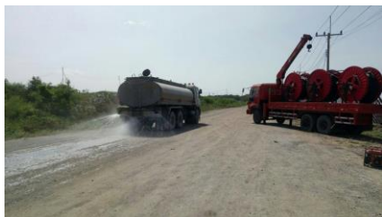
ฉีดพรมน้ำในพื้นที่ ก่อสร้าง
