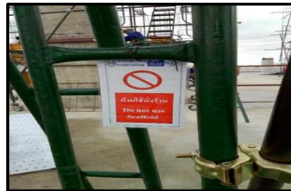
ตรวจเข็มนั่งร้าน
