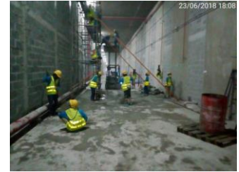
ทำความสะอาดพื้นที่ทำงาน อุโมงค์
