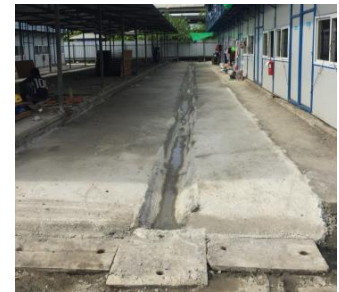
ปรับปรุงรางระบายน้ำบ้านพัก คนงาน
