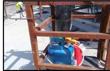
ตรวจเช็คถังลมถังแก๊ส
