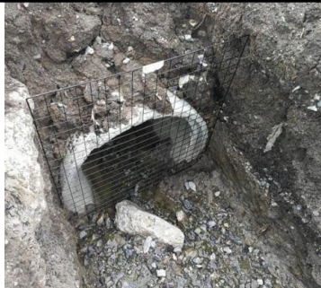
ติดตั้งตะแกรงดักขยะ
