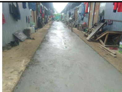
ปรับปรุงทางระบายน้ำบ้านพัก คนงาน
