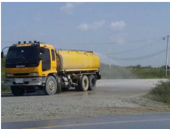
ฉีดพรมน้ำในพื้นที่ ก่อสร้าง
