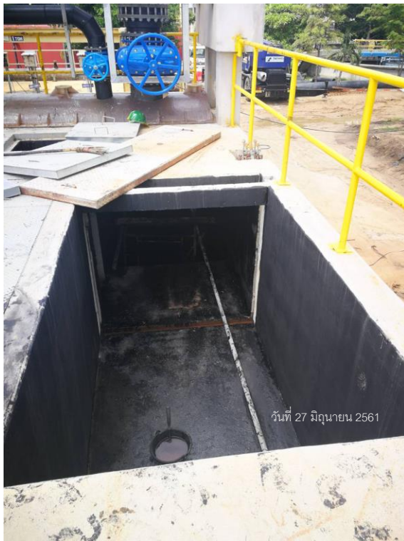
ทา Epoxy ผนังบ่อ PT1-2
