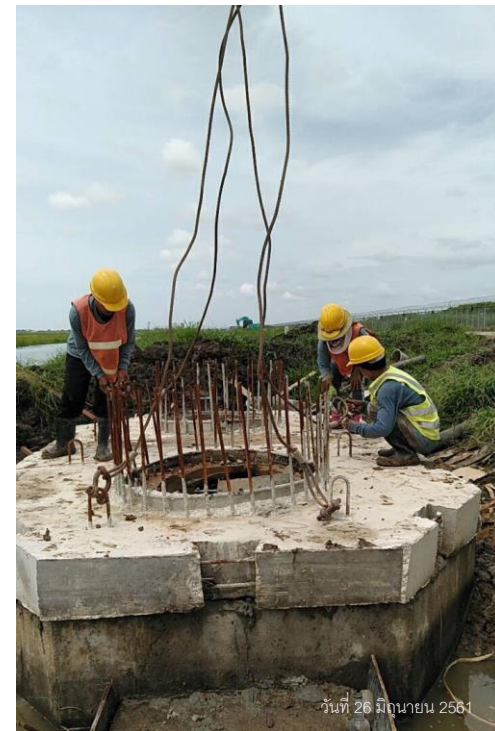
ติดตั้งฝาบ่นบ่อ
