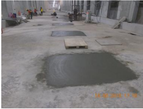
งานแก้ไข Base Plate Raking
