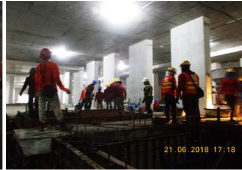
งาน Watertank APM DEPOT
