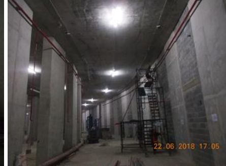
งานติดตั้งท่อระบบดับเพลิง
