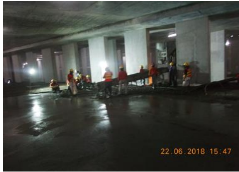
งาน SLAB APM DEPOT
