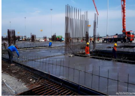
งาน Post Tension ชั้น G
