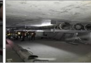
เข้าติดตั้งท่องานระบบ
