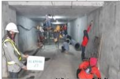
SCS และ ITD ยังไม่อนุญาตให้เข้าพื้นที่
