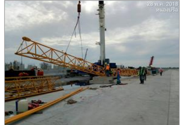
งานติดตั้ง Tower Crane (SAT-1)
