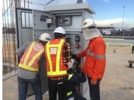
ตรวจสอบตู้ไฟฟ้า ด้านทิศใต้ (Airfield lighting)
