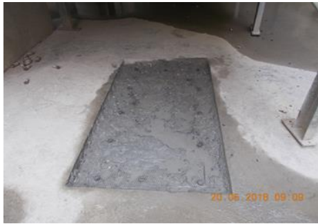
งานแก้ไข Base Plate Racking
