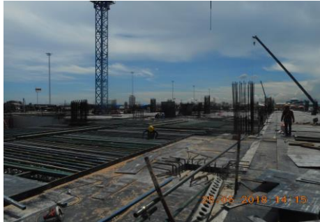
งาน Slab and Beam ชั้น B1
