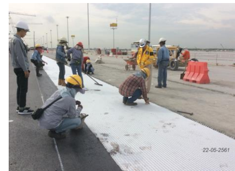
งานปูแผ่นใย Apron Culvert Reinforcement
