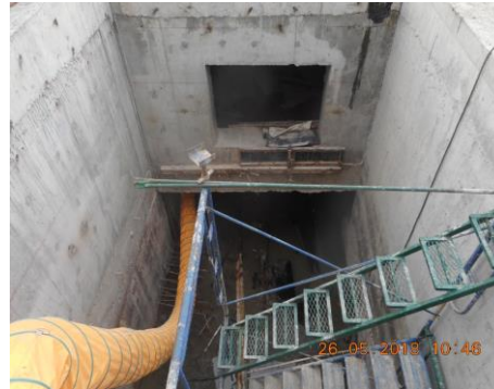
งาน Water Tank
