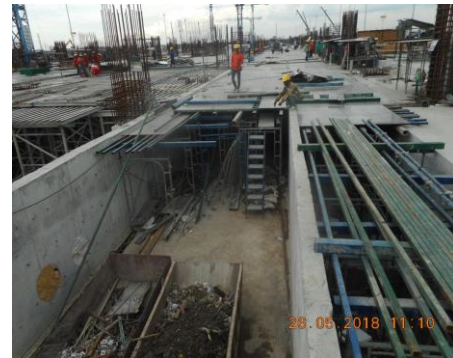
งาน Utility Tunnel
