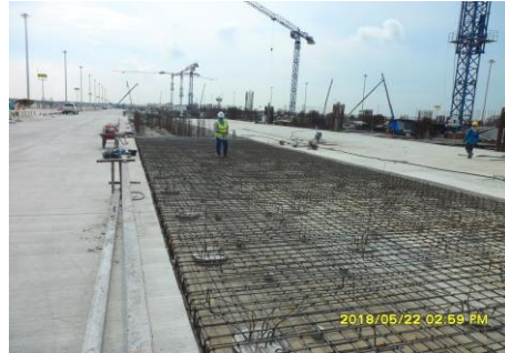
งาน Service Road
