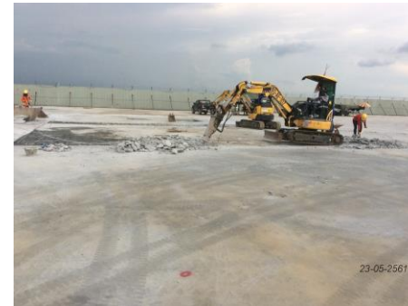
งานสกัดผิว PQC ออก, Intoplane (Airfield)
