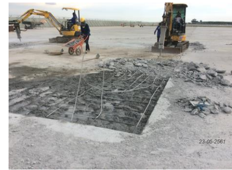
งานสกัดผิว PQC ออก, Intoplane (Airfield)
