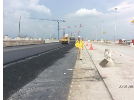
งานปูผิว Asphalt concrete
