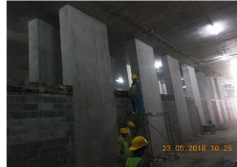
งานก่ออิฐภายในอุโมงค์ใหม่
