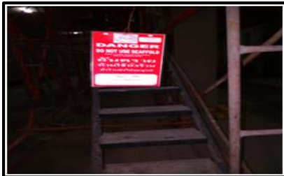
ตรวจสอบนั่งร้าน
