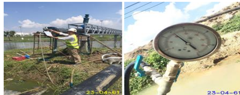
ทดสอบท่อเสี้ยน HDPE 355 มม. สัญญา CC3
