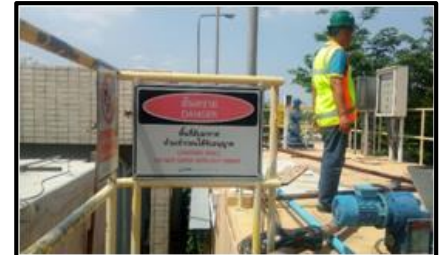
การทำงานในพื้นที่อับ อากาศ
