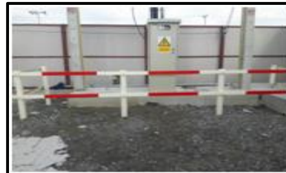
กั้นพื้นที่เสี่ยงเขตไฟฟ้า
