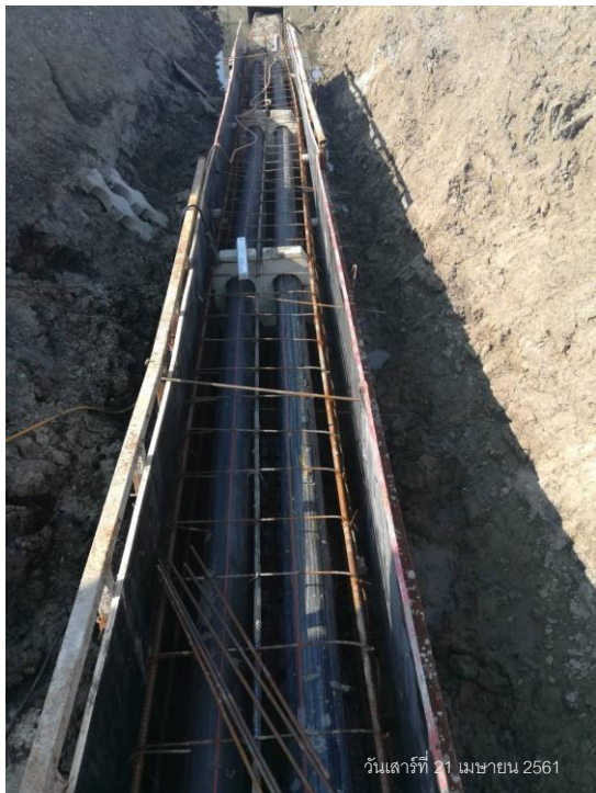
ติดตั้ง DB
