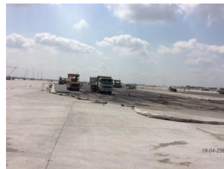
งานAsphalt Pave(TWY Shoulder)
