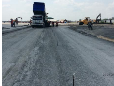
งาน Paving CTB (Airfield)
