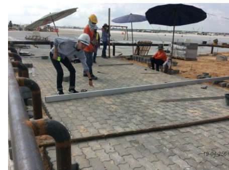
งานPaving Block(Island)
