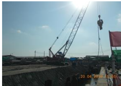
งานรื้อถอน Sheet Pile
