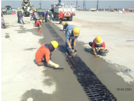
งานเทคอนกรีต Grating (Drain Channel)
