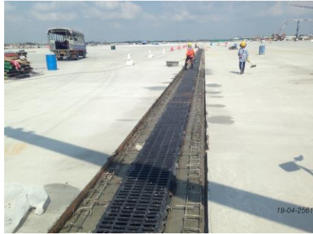
งานเทคอนกรีต Grating (Drain Channel)
