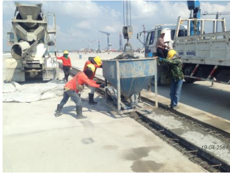
งานเทคอนกรีต Grating (Drain Channel)
