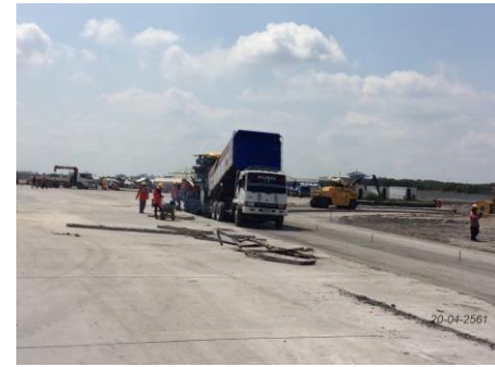
งาน Paving CTB (Airfield)
