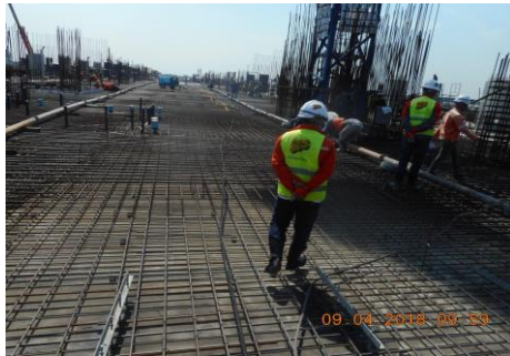
งาน Slab and Beam ชั้น B1
