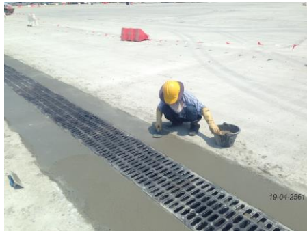
งานเทคอนกรีต Grating (Drain Channel)
