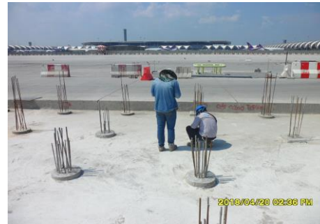
งาน Pile Cap and Test
