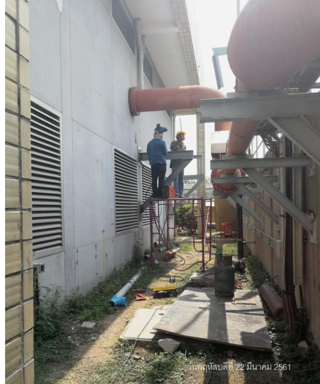
Pipe rack รับท่ออากาศ
