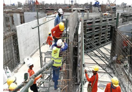
งาน Utilities Tunnel
