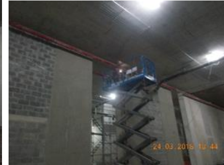
งานติดตั้งท่อระบบป้องกัน อัคคีภัย Existing Tunnel 7
