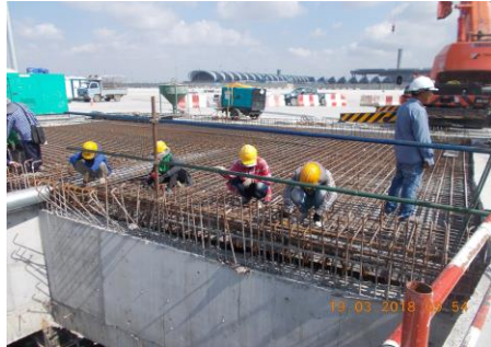
งาน Slab and Beam ชั้น B1
