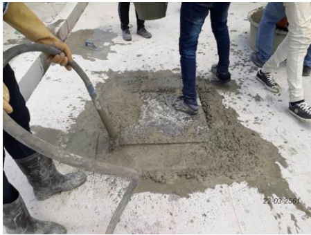
งาน Grating Top Slab (Taxiway Strip Box Culvert)
