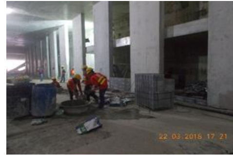
งานก่ออิฐภายในอุโมงค์ใหม่
