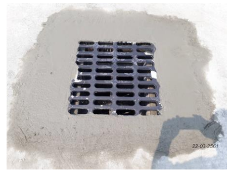
งาน Grating Top Slab (Taxiway Strip Box Culvert)
