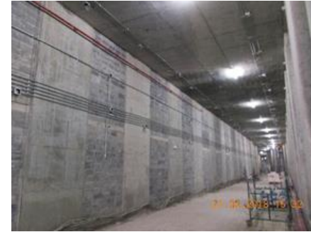
งานติดตั้งท่อ Conduit ระบบไฟฟ้า New Tunnel
