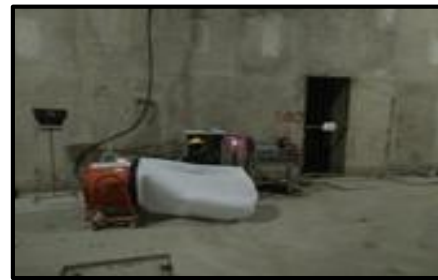
ติดตั้งถ่วงดักฝุ่นในอุโมงค์
