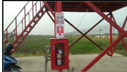
ตรวจถังดับเพลิง
