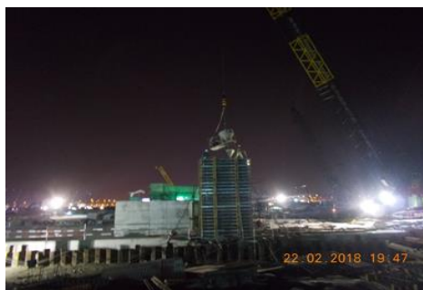
งาน Vent Shaft
