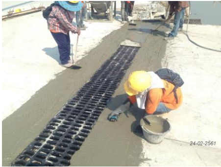
งาน Drain Channel
