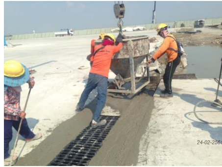
งาน Drain Channel
