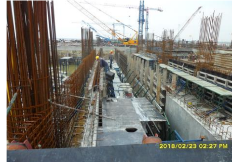
งาน Utilities Tunnel
