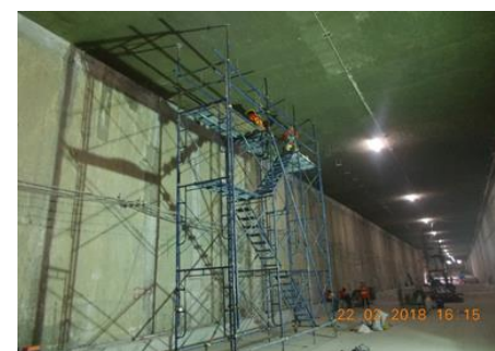
งานติดตั้งท่อ Conduit ระบบไฟฟ้า Existing Tunnel
