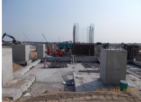
งาน Boarding Bridge (Footing)
