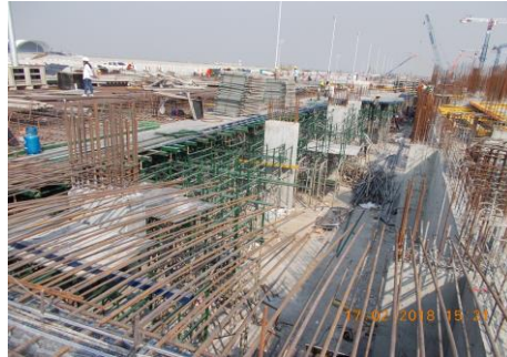
งาน Slab and Beam ชั้น B1
