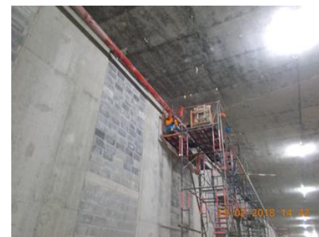
งานติดตั้งท่อระบบป้องกัน อัคคีภัย New Tunnel
