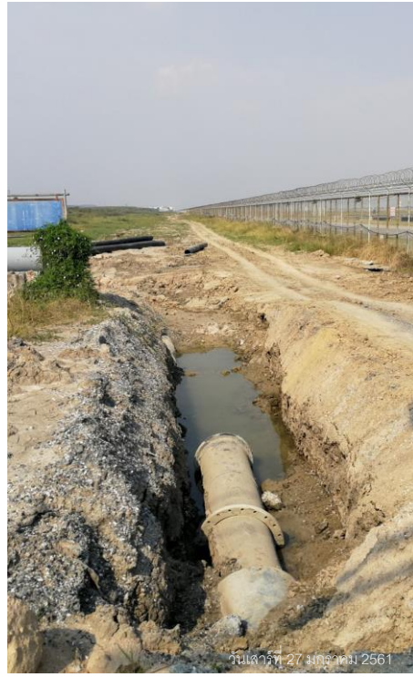
งานท่อน้ำประปาเดิม
