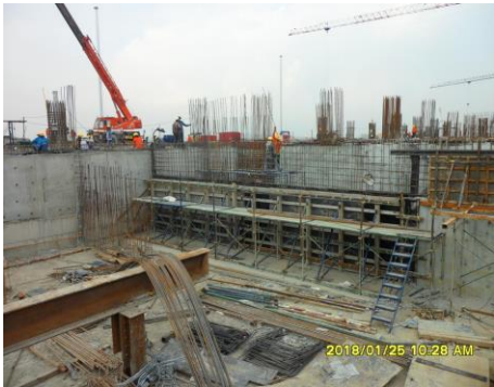
งาน Underground Water Tank
