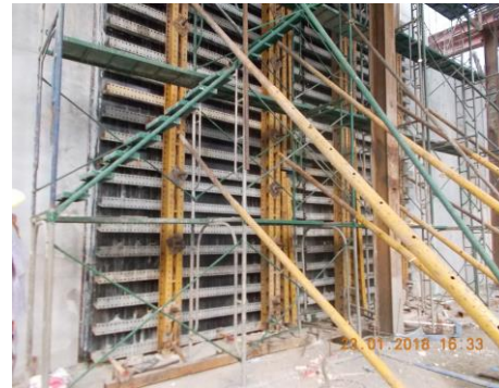
งาน RC Wall
