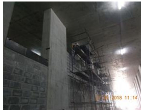
งานก่ออิฐภายในอุโมงค์ใหม่
