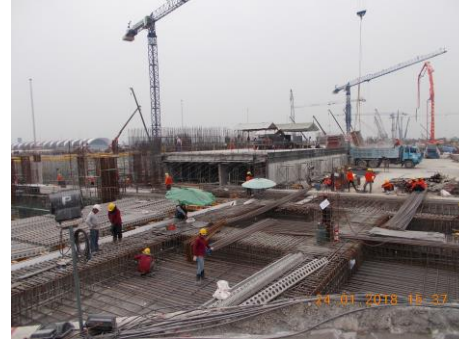
งาน Utilities Tunnel
