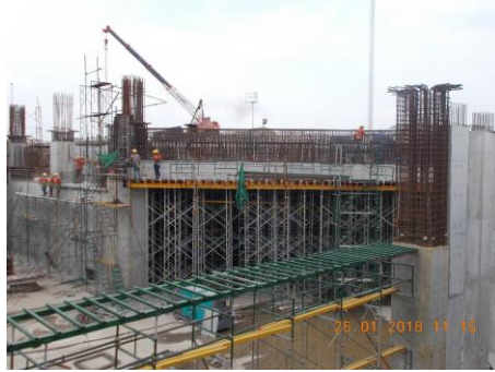
งาน Slab and Beam ชั้น B1
