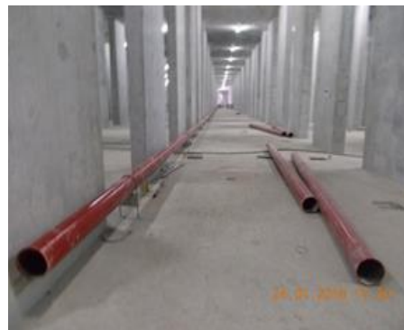
งานติดตั้งท่อระบบป้องกัน อัคคีภัย New Tunnel
