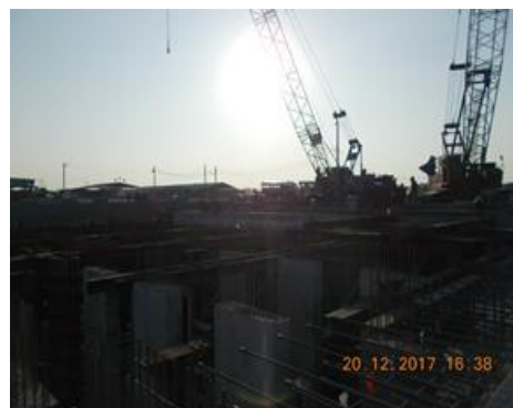
งาน Delete Platform & Bracing
