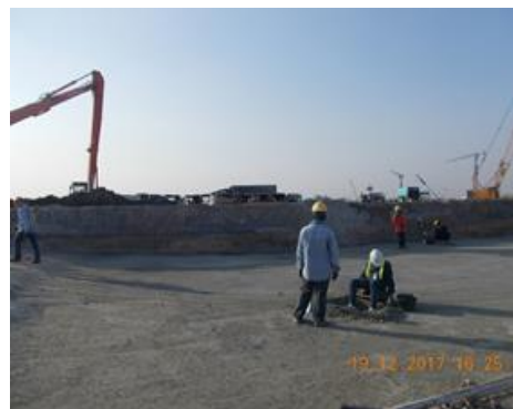
งานทดสอบ Aggregate Base Course
