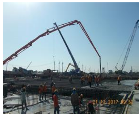
งาน Roof Slab
