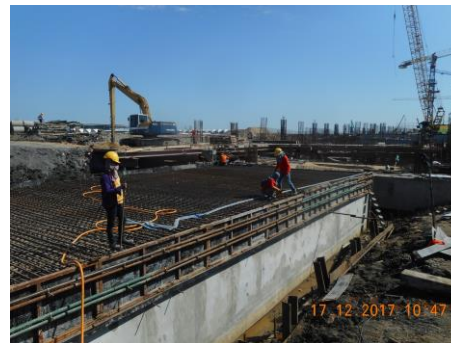
งาน Utilities Tunnel
