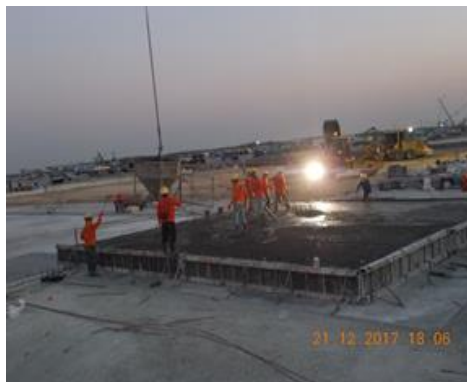
งาน Transition Slab
