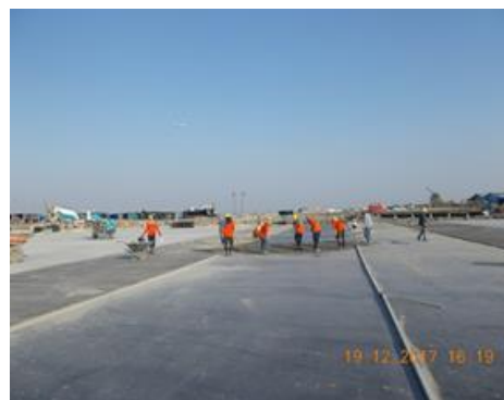
งาน Waterproof Membrane and Topping Roof Slab.
