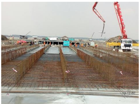
งาน Taxiway Strip Box Culvert
