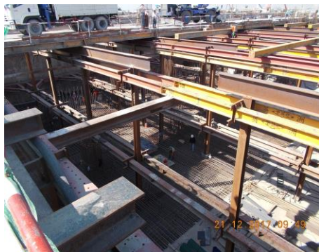
งาน Slab and Beam ชั้น B2
