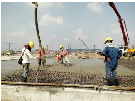
งาน Taxiway Strip Box Culvert
