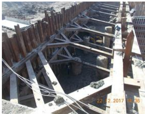
งาน Base Slab
