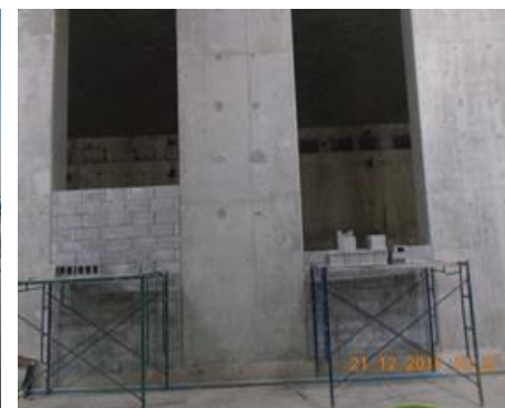
งานก่ออิฐภายในอุโมงค์ใหม่ 8
