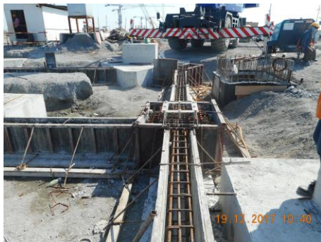
งาน Boarding Bridge (Footing)
