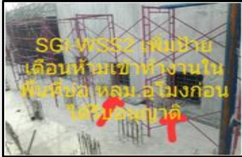
ก่อนแก้ไข ไม่มีป้ายเตือน
