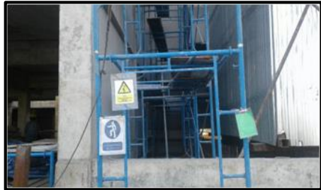
ติดป้ายเตือน
