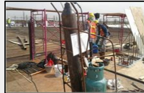
หลังแก้ไข จัดให้ถังลมแก๊สให้อยู่ในสภาพที่ปลอดภัย
