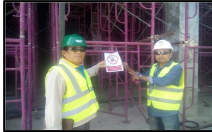
ตรวจสอบนั่งร้าน
