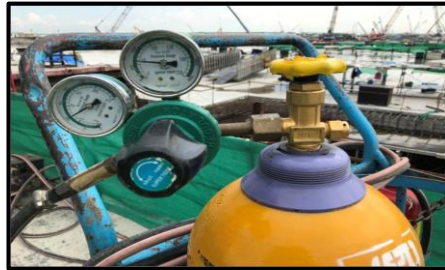
ตรวจสอบอุปกรณ์ตัดแก๊ส
