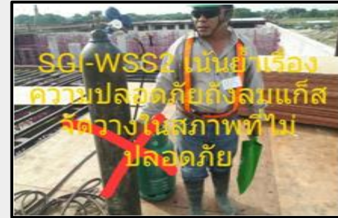
ก่อนแก้ไข ถึงลมแก๊สจัดวางในสภาพที่ไม่ปลอดภัย
