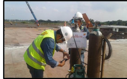
ตรวจเช็คถังลมถังแก๊ส
