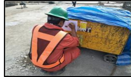
ตรวจเช็คอุปกรณ์ เครื่องจักร
