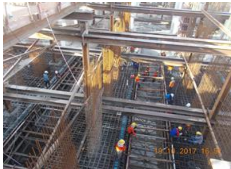
งาน Base Slab
