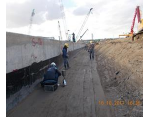
งานบดอัดทราย พร้อมทดสอบ ความหนาแน่น 5
