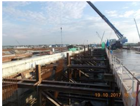
งานติดตั้ง Raking ค้ำ D-Wall
