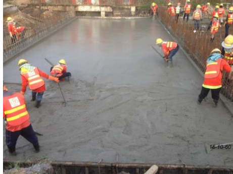
งาน Road Culvert No. 51
