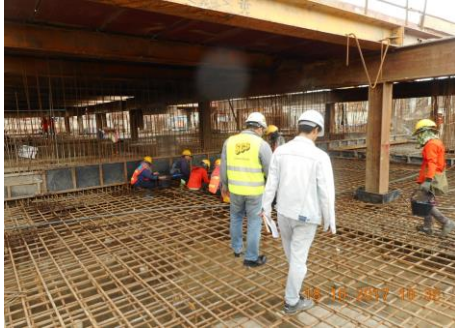
งาน Underground Water Tank
