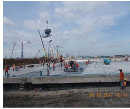
งาน Waterproof Membrane and Topping Roof Slab.
