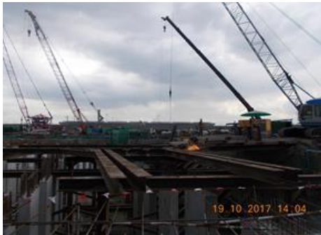
งาน Delete Platform & Bracing
