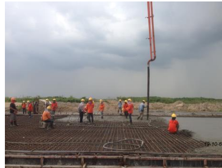
งาน Taxiway Strip Box Culvert
