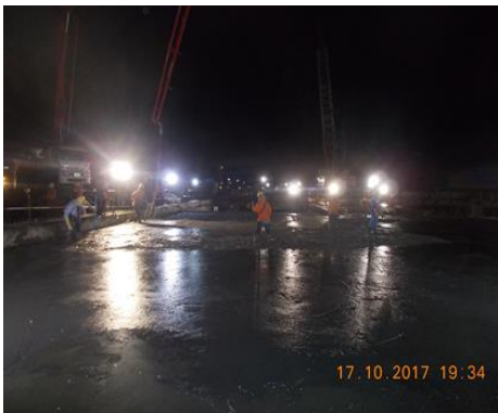
งาน Roof Slab
