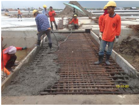
งาน Apron Culvert
