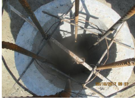
งาน Boarding Bridge (Footing)
