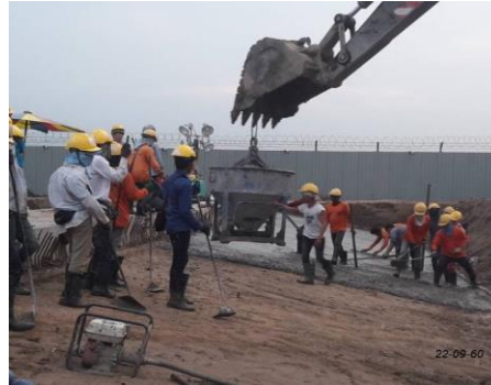
งาน Apron Culvert
