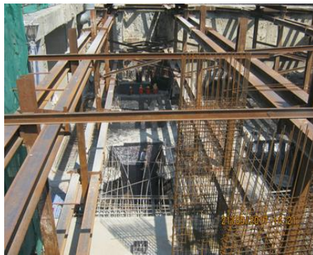
งาน Base Slab
