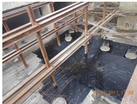
งาน Waterproof Membrane
