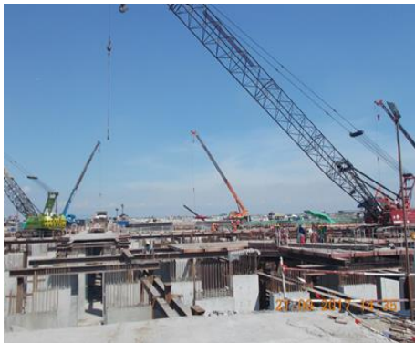
งาน Delete Platform & Bracing
