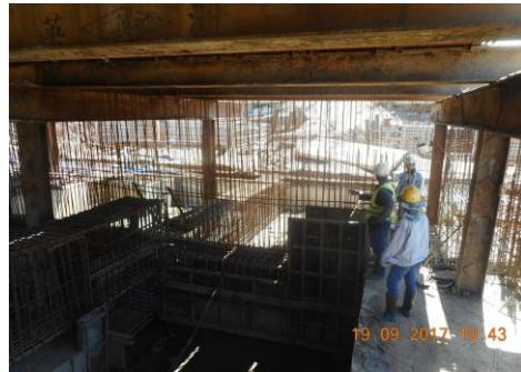
งาน Underground Water Tank
