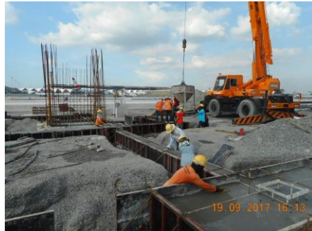
งาน Boarding Bridge (Footing)
