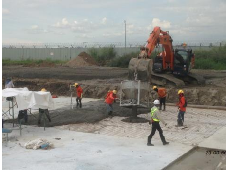
งาน Secondary Canal
