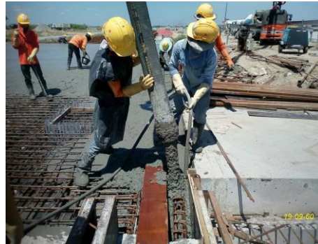
งาน TWY Strip Box Culvert
