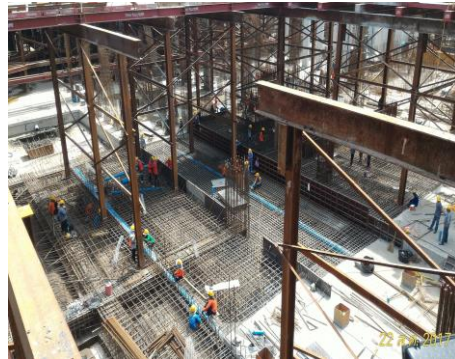
งาน Slab and Beam ชั้น B2
