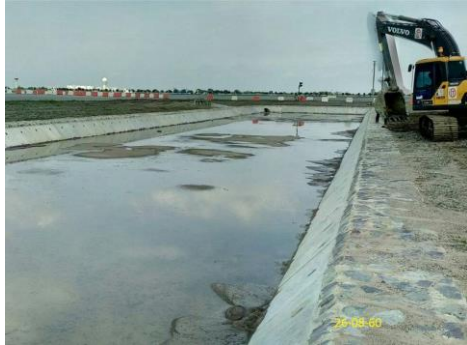
งาน Secondary Canal
