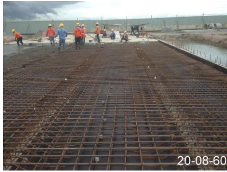
งาน TWY Strip Box Culvert
