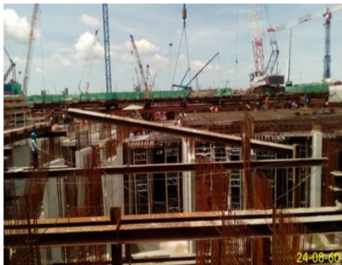
งาน Delete Platform & Bracing
