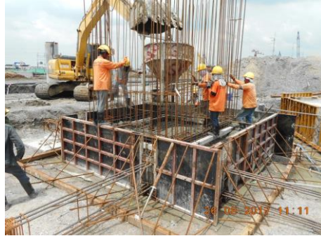
งาน Boarding Bridge (Footing)
