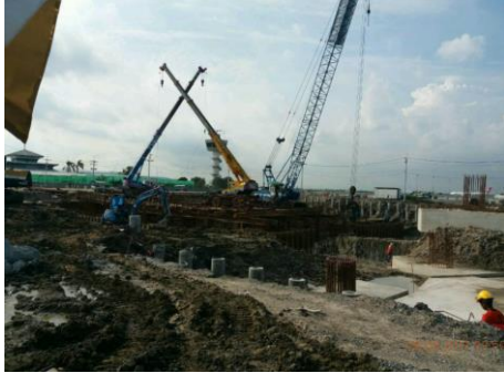
งาน Underground Water Tank
