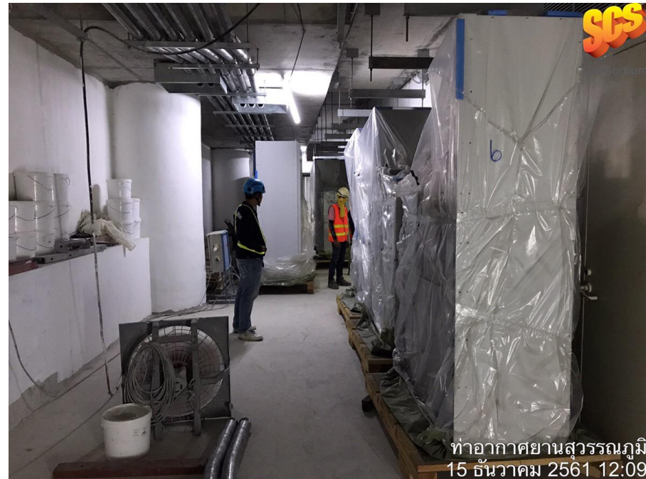
งานติดตั้ง Switchgear
