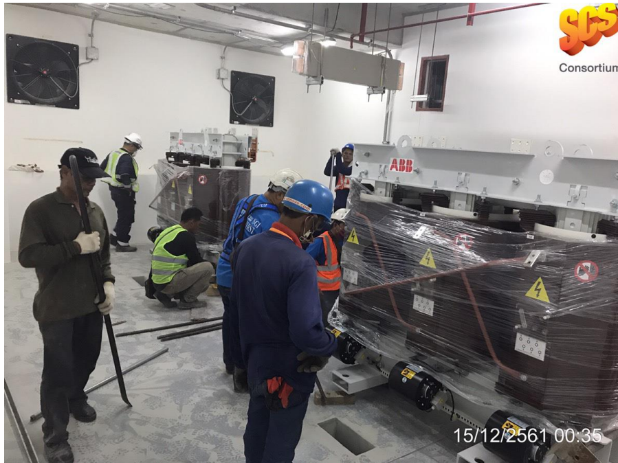
งานติดตั้งหม้อแปลง
