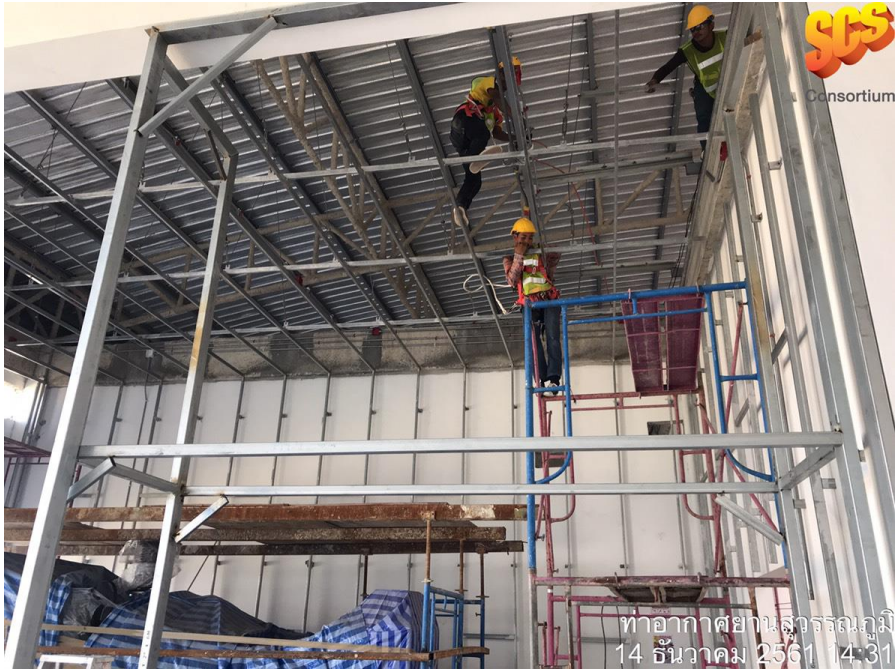
ติดตั้งโครง support ผนังทนไฟ
