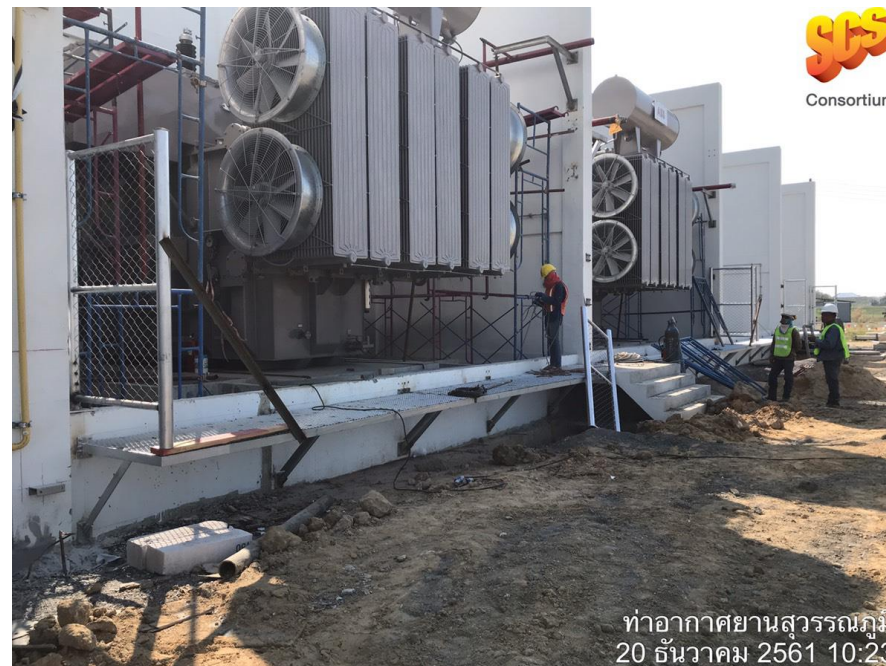
งานติดตั้งรั้ว Chain Link
