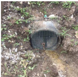
ติดตั้งตะแกรงดักขยะในรางระบายน้ำ
