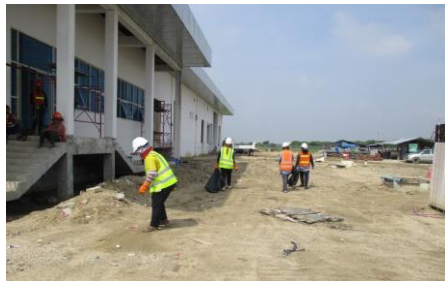
จัดเก็บขยะในพื้นที่ก่อสร้าง
