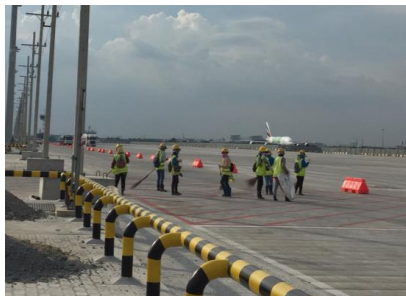
ทำความสะอาดพื้นที่ก่อสร้าง
