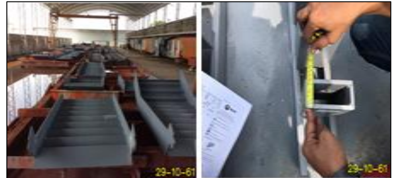
ประกอบบันไดเหล็ก Boarding Bridge CC1.2
