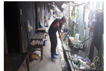
ทำความสะอาดรางระบายน้ำบ้านพักคนงาน
