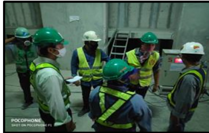
ตรวจพนักงานก่อนเข้าอุโมงค์
