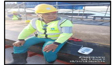
การตรวจวัดความดันก่อนเริ่มงาน
