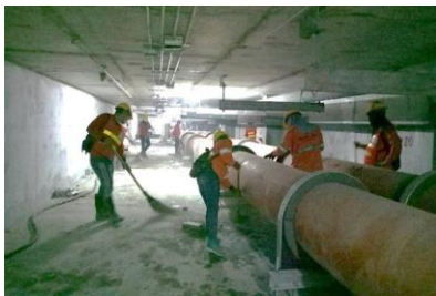
การทำความสะอาด Utility Tunnel
