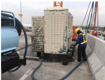
สูบล้างอุปกรณ์กรองน้ำในพื้นที่ก่อสร้าง
