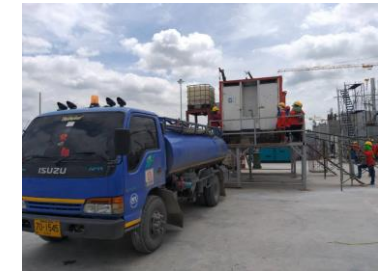
สูบล้างอุปกรณ์บริเวณหน้างาน
