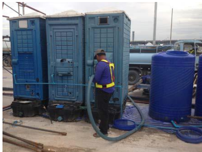
สูบล้างปฏิภาณห้องน้ำในพื้นที่ก่อสร้าง
