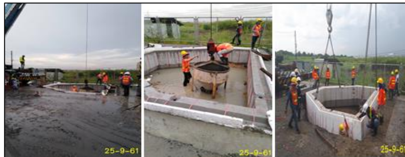
ทดสอบแท่นตัวอย่างพื้น Post ชั้น G อายุ 7 วัน CC1.2
