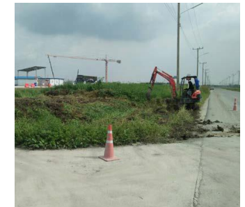
กำจัดขยะบนเส้นทางระบายน้ำ
