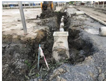
ปรับปรุงทางระบายน้ำในพื้นที่เตรียมงาน
