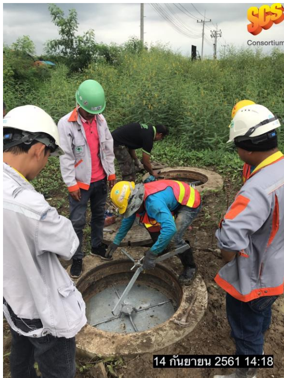
ปิดฝาใน บ่อMH.1(24kv) บริเวณLandside ตะวันตก
