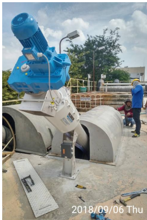
ติดตั้งเครื่องดักขยะแบบ ละเอียด บ่อ PT-2
