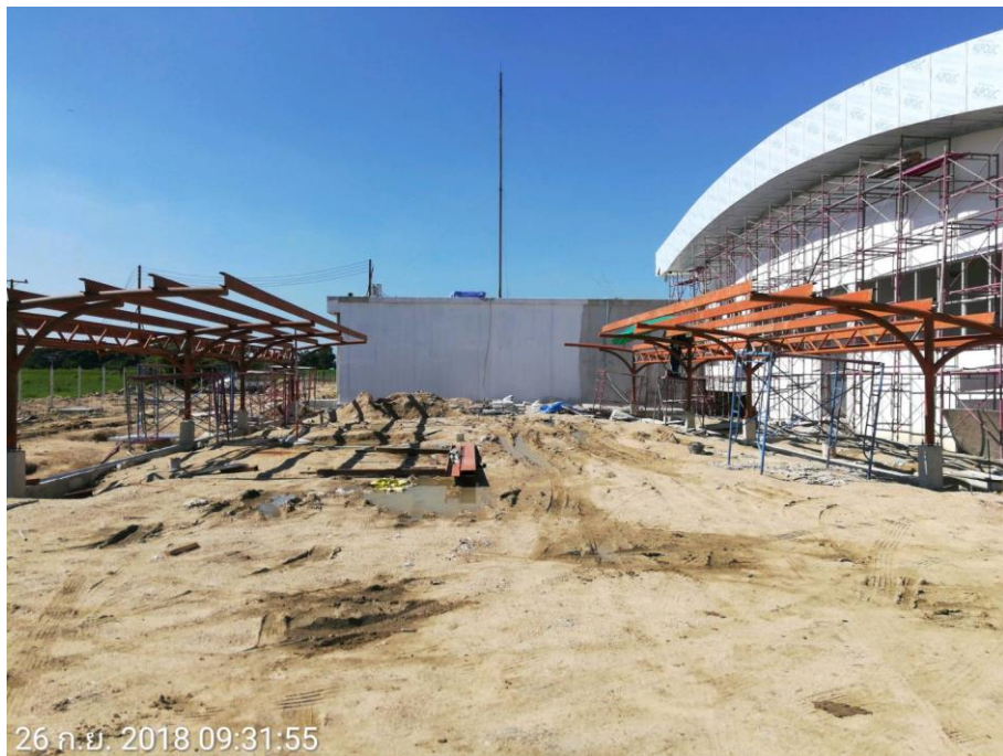
งานโครงหลังโรงจอดรถ ข้างอาคาร
