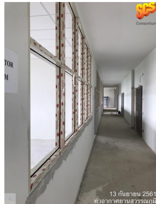
งานติดตั้งวงกบหน้าต่างอลูมิเนียม
