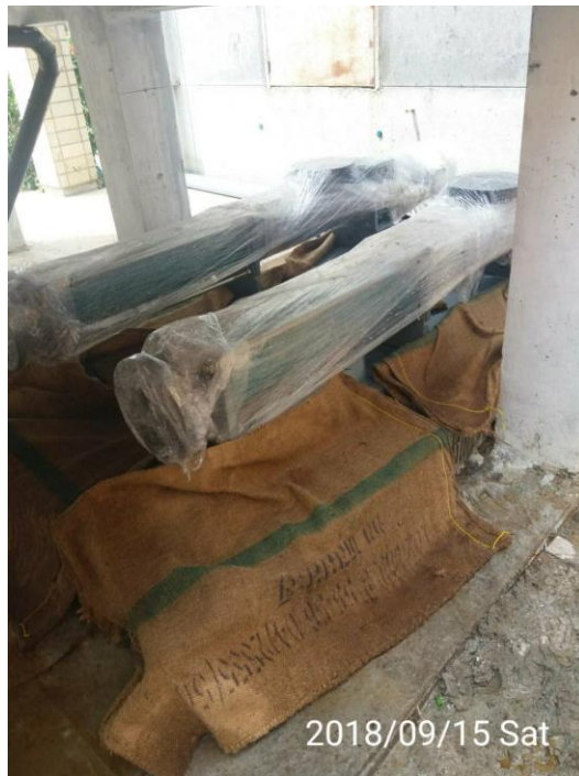
ติดตั้งเครื่องลำเลียงของแข็ง บ่อ PT- 2
