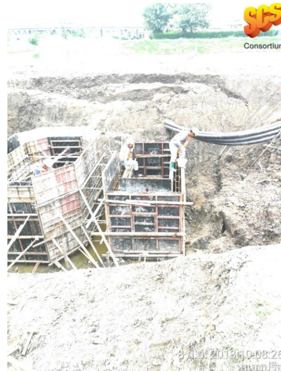
เข้าแบบผนังบ่อMH.58(24kv) ,MH.37(Scada) บริเวณ Landside ตะวันออก
