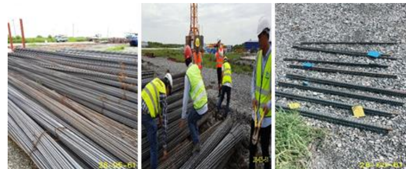
ตัดเหล็กตัวอย่างก่อนใช้งานไปทดสอบ สัญญา CC1.2
