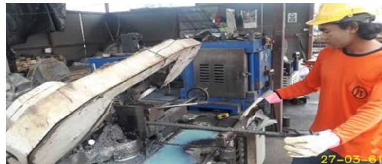
ตัดเหล็กตัวอย่างไปทดสอบของ Set-1 สัญญา CC1.1
