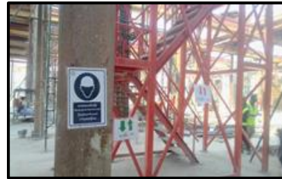
ติดป้ายสัญลักษณ์ด้านความปลอดภัยฯ
