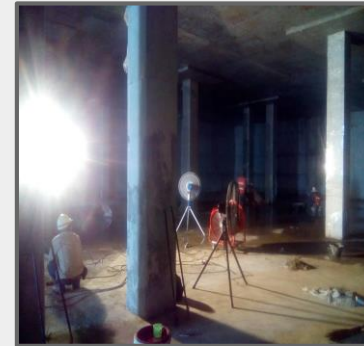
หลังแก้ไข จัดให้มีแสงสว่างในพื้นที่การทำงาน
