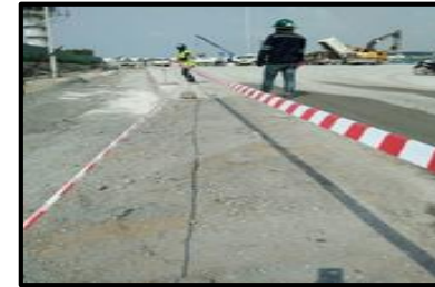
การกั้นเขตพื้นที่การทำงานและพื้นที่เสี่ยงอันตราย
