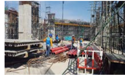
ตรวจสอบงานยก
