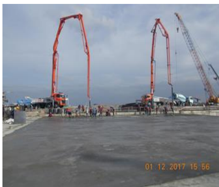
งาน Roof Slab
