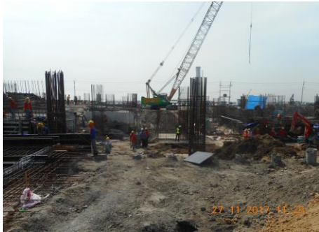
งาน Underground Water Tank
