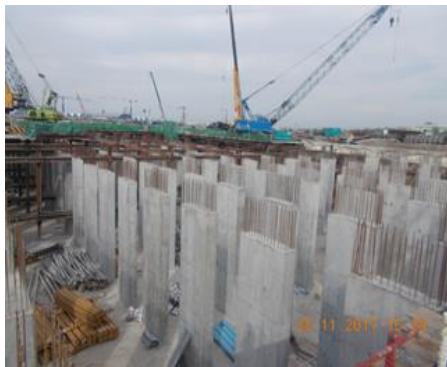
งาน Delete Platform & Bracing
