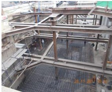
งาน Base Slab
