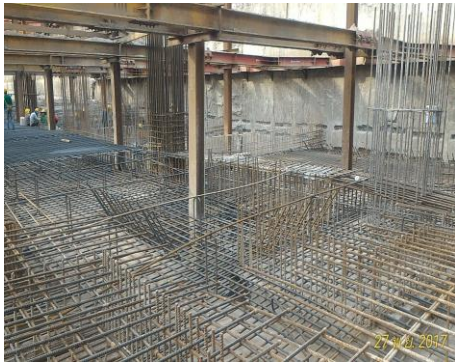
งาน Slab and Beam ชั้น B2
