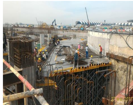
งาน Slab and Beam ชั้น B1
