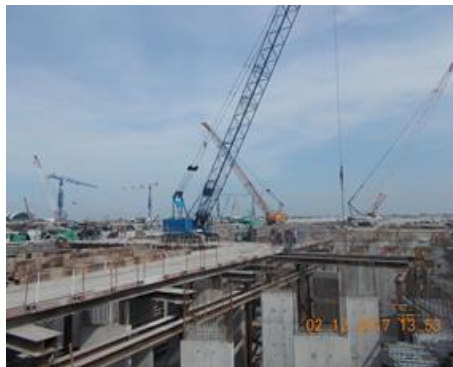
งานร้อยถอน Bracing & Kingpost
