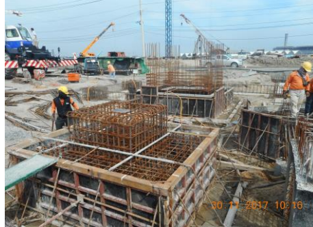
งาน Boarding Bridge (Footing)
