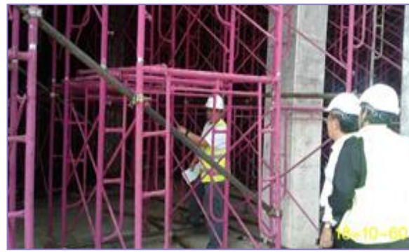
ตรวจสอบความแข็งแรงของนั่งร้านรับพื้น Top Slab ของ WSS2, CC3
