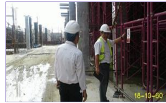
ตรวจสอบความแข็งแรงของนั่งร้านรับพื้น Top Slab ของ WSS2, CC3
