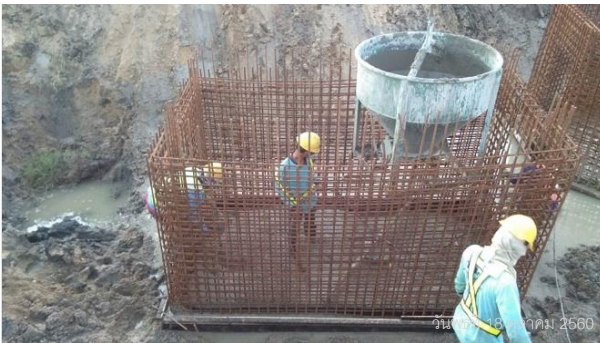
เทคอนกรีตบ่อ MH
