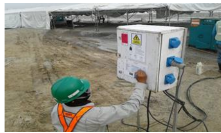
ตรวจตู้ไฟฟ้า
